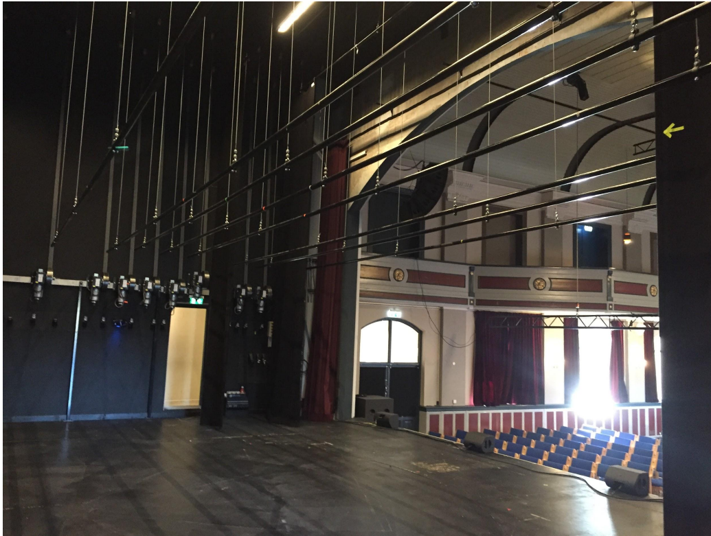
9 motoriserede træk fordelt på forreste halvdel af scenen
